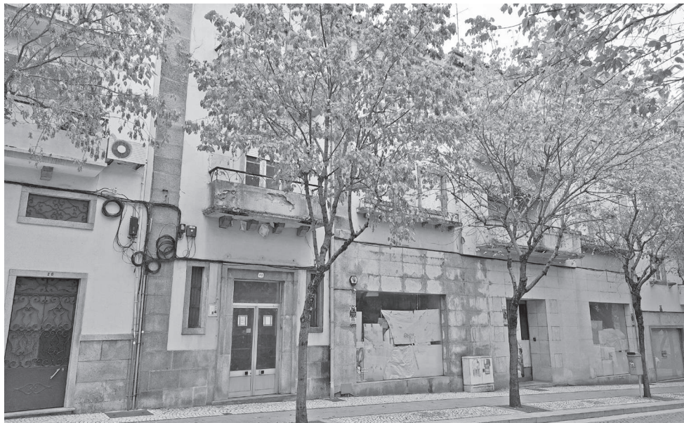
A Pensão Residencial Arraiana localizava-se na Avenida 1.º de Maio
