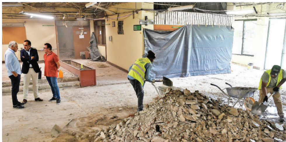
As obras de requalificação na ESE estão a decorrer
