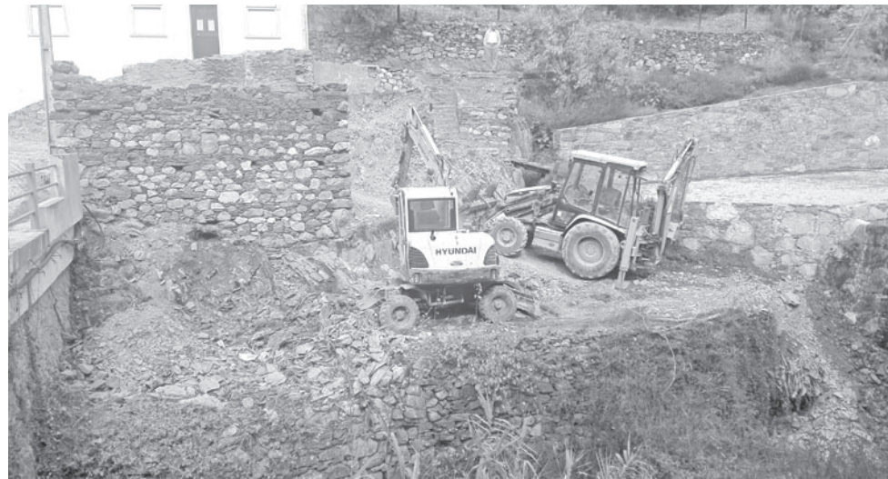
As obras de valorização já começaram
